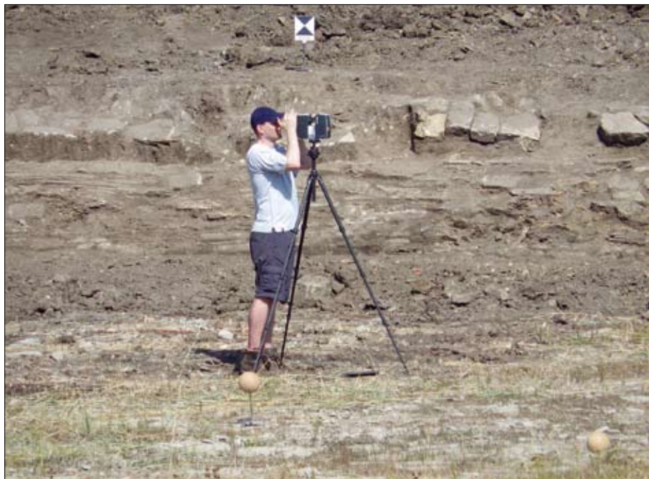
Obr. 22: 3D skenování opevnění břehů Pstružího rybníka. (Foto J. Janál)
