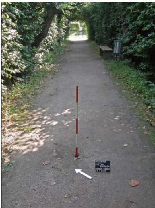
Obr. 16: Drobný otvor v cestě mezi Jahodovými kopečky v kroměřížské Kočetné zahradě indikuje poruchu v trase historického kanálu. Dvoumetrová trasírka dokazuje, že dno dutého prostoru se nachází 1,10 m pod úrovní cesty. (Foto J. Janál)
