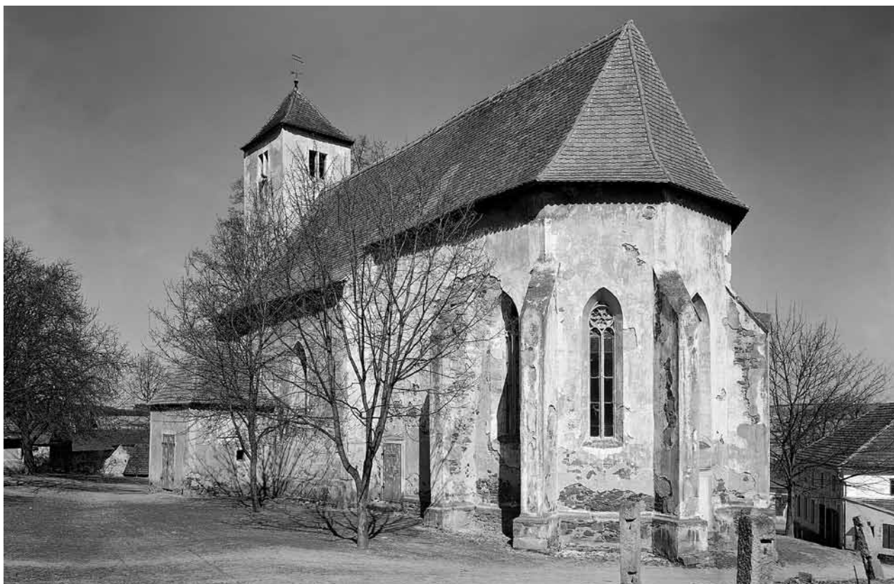
Obr. 18. Bukovec, kostel Nanebevzetí Panny Marie. Pohled od jihovýchodu. (Fotoarchiv Národního památkového ústavu, generální ředitelství, foto V. Hyhlík, 1951)
