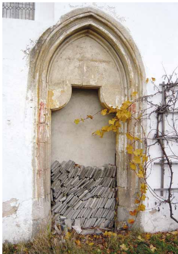
Obr. 21. Stanětice (okr. Domažlice), kostel sv. Kunhuty. Zazděný jižní portál do lodi. (Foto J. Kaigl, 2006)
