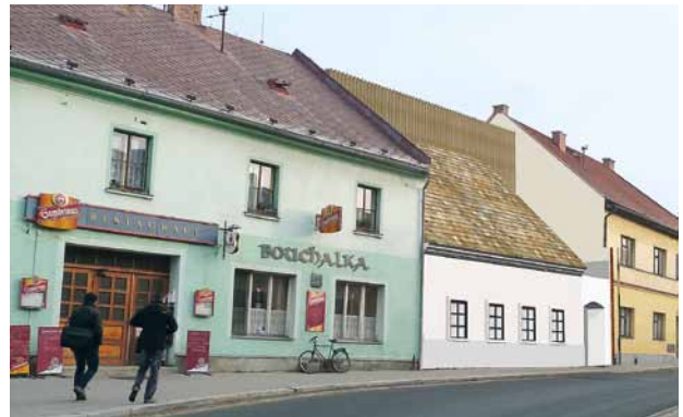
Obr. 4. Sušice, Nuželická ulice, dům čp. 106/III. Vizualizace návrhu celkové stavební adaptace a přístavby. Uliční pohled od jihozápadu. (Převzato z Rekonstrukce domu v Sušici, Sušice/Nuželická ulice/čp. 106/III, architektonická studie, Zábran – Nová architekti, 2013)
