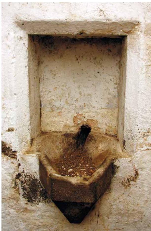
Obr. 8. Nezamyslice, kostel Nanebevzetí Panny Marie. Přízemí severní zdi věže. Nika s lavabem v tlouštkce severní zdi. (Foto R. Lavička, 2015)
