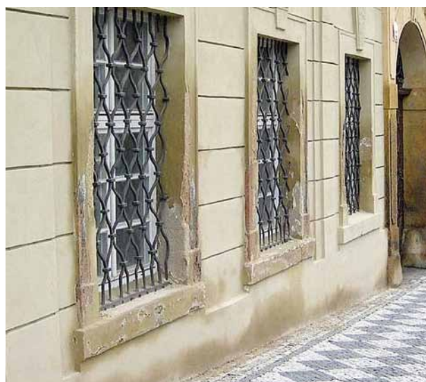
Obr. 3, 4. Praha 1 – Hradčany, dům čp. 161/IV (U Zrcadla). Západní část hlavního (jižního) průčelí do ulice Úvoz – přízemí a první patro. Část přízemí. – Aplikací vnitřně hydrofobizovaných omítek při opravě historické fasády dochází k poškození všech jejích prvků provedených z nasákavého materiálu, na které působí zemní vlhkost. Nejde tedy jen o omítky, ale například i omítaná kamenná ostění oken. V nich se při nadměrné vlhkosti zachytí velké množství hyroskopických solí, které na sebe dále váží molekuly vody. Proto se po čase na ostění objeví výkvěty solí, tenké vrstvy omítky či vysprávek se odlupují a kámen se začne drolit.
