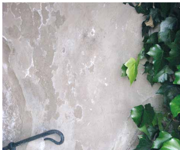
Obr. 7, 8. Praha 1 – Malá Strana, komplex palácových zahrad pod Pražským hradem. Části omítaného zdiva. – Lokální opravy nenasákavých omítek jsou prakticky nemožné. Kolem vysprávký vznikne tenká spára, kterou proniká a odpařuje se voda. Vysprávka se nejprve vykreslí po svém okraji z krystalků soli (obr. 8). Později se omítka oddělí od zdiva. Nápravě stavu zpravidla dlouhodobě nepomůže ani opakovaný fasádní nátěr (obr. 7). (Všechny snímky z archivu autorky, 2010–2015)
