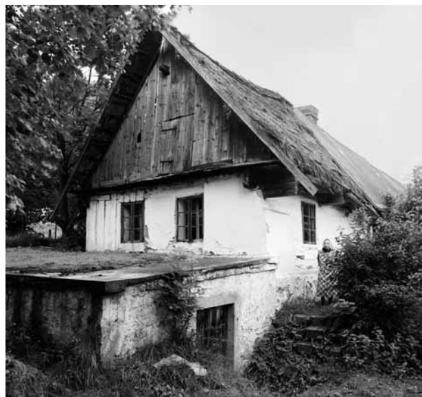
Obr. 1. Újezdec (okr. Klatovy), usedlost čp. 7. Štítové průčelí přední části domu. Vnějšíkovým rozpoznávacím znamením existence krovu na kobylu je uplatnění koncové části vaznic před plochou horní částí štítu. (Foto J. Škabrada, 1979)
