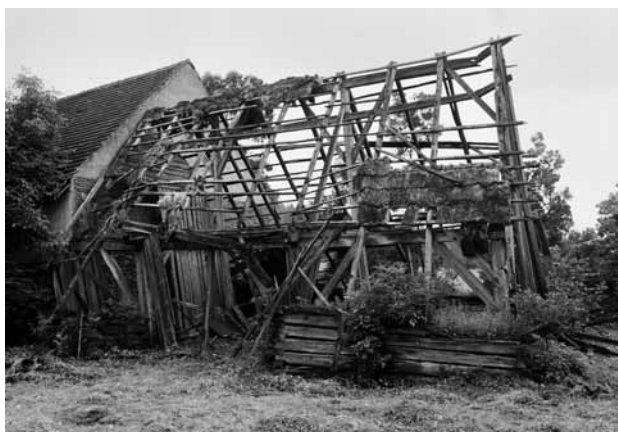
Obr. 2. Újezdec, usedlost čp. 7. Dožívající konstrukce stodoly, zba- vená střešní krytina. Kromě hřebenového vazníku na čtyřech slou- pech, jejichž umístění tvoří základní rozvrh stavby, je patrné rá- mové jádro spodní části objektu s výškou vjezdu na mlat. Střecha mimo vrata pokračovala dolů a končila až na nízkých roubených obvodových stěnách. (Foto J. Škabrada, 1979)
