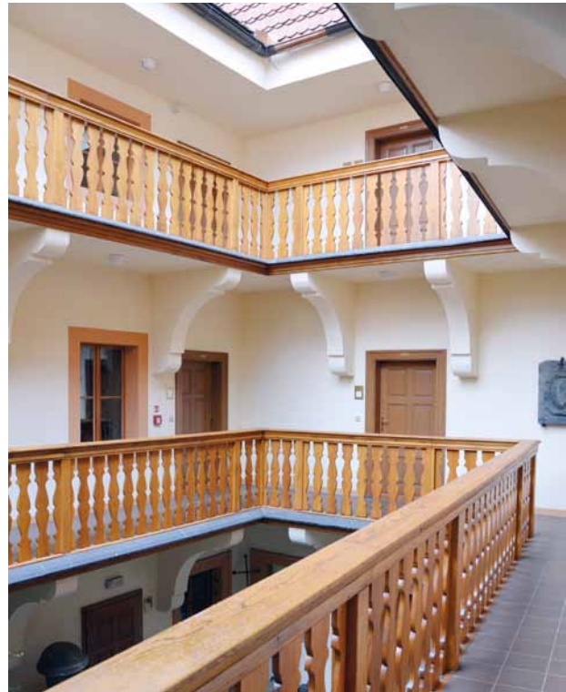
Plzeň, dům U Zlatého slunce. Dvorní fasády a pavlače po renovaci. (Foto J. Kaigl, 13. 1. 2015)
