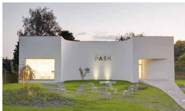
Obr. 4. Klatovy, areál Vlastivědného muzea Dr. Hostaše, pavilon skla – PASK. Pohled od východu na vstupní průčelí. (Foto M. Břízová, 2015)
