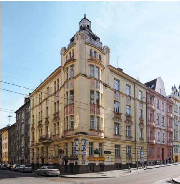
Obr. 11. Plzeň – Jižní Předměstí. Dům na nároží ulic Bendova a Koperská. (Foto K. Kuča, 2013)
