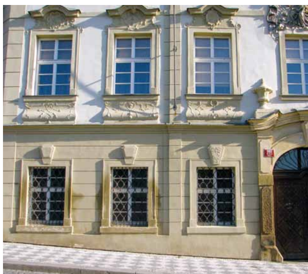
Obr. 3, 4. Praha 1 – Hradčany, dům čp. 161/IV (U Zrcadla). Západní část hlavního (jižního) průčelí do ulice Úvoz – přízemí a první patro. Část přízemí. – Aplikací vnitřně hydrofobizovaných omítek při opravě historické fasády dochází k poškození všech jejích prvků provedených z nasákavého materiálu, na které působí zemní vlhkost. Nejde tedy jen o omítky, ale například i omítaná kamenná ostění oken. V nich se při nadměrné vlhkosti zachytí velké množství hyroskopických solí, které na sebe dále váží molekuly vody. Proto se po čase na ostění objeví výkvěty solí, tenké vrstvy omítky či vysprávek se odlupují a kámen se začne drolit.
