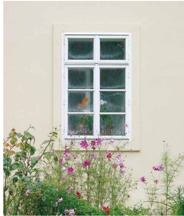
Obr. 5, 6. Praha 6 – Liboc, areál obory Hvězda, dům čp. 1 (dům oborníka). Část jižní fasády a jedno z oken přízemí. – Existují případy, kdy byly vnitřně hydrofobizované omítky použity při opravě fasád a současně i v interiéru. Omítky sice nejsou ani po několika letech poškozeny, ale ze stále přítomnosti vnitřní vlhkosti kondenzující na oknech lze odvodit, že stavba trpí. Nenasákavé omítky nemají schopnost pohlcovat ani provozní vlhkost a interiéry jsou nadměrně vlhké včetně vysokého rizika vzniku plísní.
