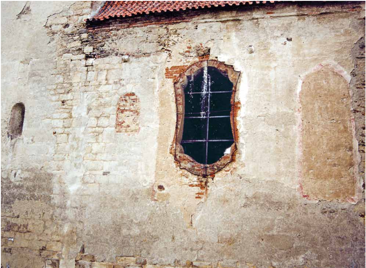
Obr. 2. Horšov (okr. Domažlice), kostel Všech svatých. Pohled na část jižního průčelí lodi. Je dobře patrné například umístění barokního kasulového okna na místě vysokého gotického okna, zazděné románské okno (vlevo) a zazděné gotické okno (docela vpravo), románské kvádrové zdivo, románské okno prostoru v patře pod koutovou věží (původně na tribunu; docela vlevo) a torza dvou konzol v úrovni okapu průčelí románské svatyně. (Foto J. Bradna, 2001)
