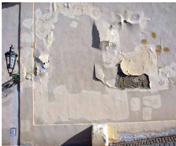
Obr. 7, 8. Praha 1 – Malá Strana, komplex palácových zahrad pod Pražským hradem. Části omítaného zdiva. – Lokální opravy nenasákavých omítek jsou prakticky nemožné. Kolem vysprávký vznikne tenká spára, kterou proniká a odpařuje se voda. Vysprávka se nejprve vykreslí po svém okraji z krystalků soli (obr. 8). Později se omítka oddělí od zdiva. Nápravě stavu zpravidla dlouhodobě nepomůže ani opakovaný fasádní nátěr (obr. 7). (Všechny snímky z archivu autorky, 2010–2015)
